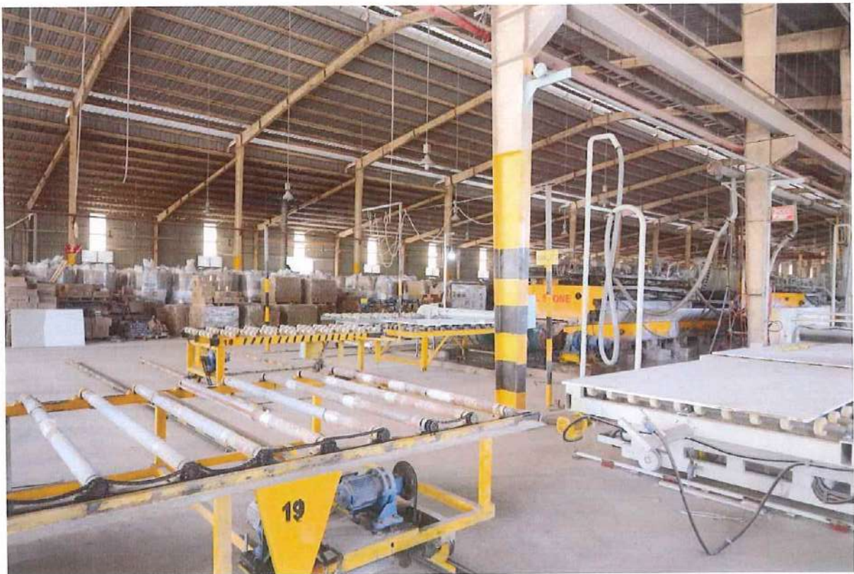
Hệ thống băng tải điều phối gạch qua dây chuyền mài hoàn thiện và đóng gói
